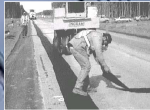
การสร้างถนนที่มีไหล่ทางลาดด้วยแอสฟัลท์
